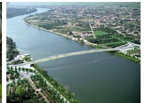
PUENTE SOBRE EL RIO EBRO
